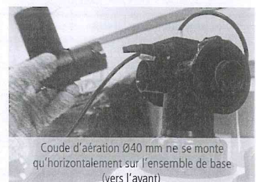
Etape 12- Emboîter le coude aération Ø40 (7) dans le raccord de base (1).
